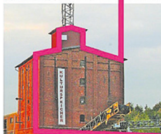
Die drei Ausstellungsorte der „Herbstgäste“ (von oben): der Schultenhof-Kunstspeicher in Mettingen, die Alte Honigfabrik in Ibbenbüren und der Dörenther Kulturspeicher. Foto: Kunstverein
